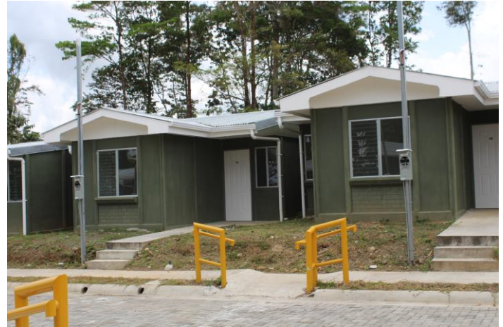
Con los recursos del impuesto solidarios, se construyó el proyecto San Martín, en Jiménez de Pococí, que dio vivienda a 117 familias en situación necesidad de ese cantón limonense.
