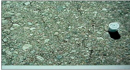
Superficie apta para la colocación de un “fog seal”. Mezcla densa altamente envejecida.
